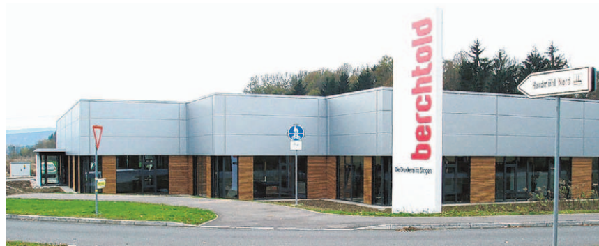
Der moderne Flachbau soll Innovation und Eleganz des Unternehmens zum Ausdruck bringen.
